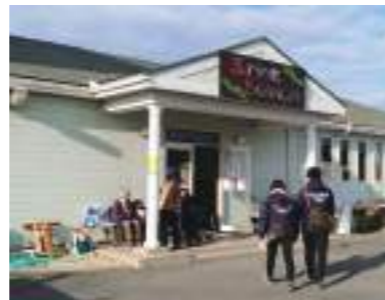
小規模多機能ホームの修繕
